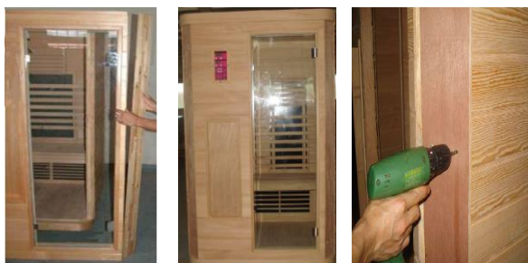
FIGURA-9 Instalati bara de conexiune si panoul frontal
