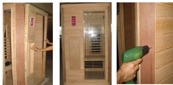
FIGURA-10 Instalati panoul frontal
