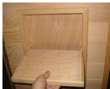
FIGURA-15 Instalați raftul
