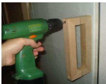
FIGURA-14 Instalați mânerul ușii
